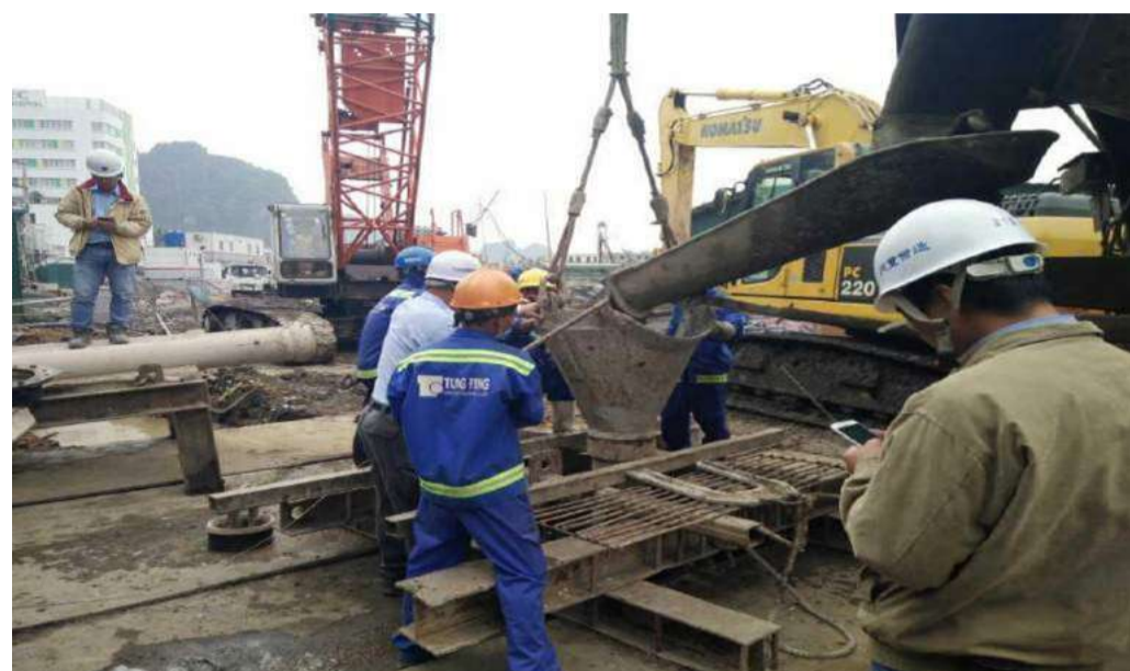
I supervise Tung Feng pour concrete for trial - pile.
